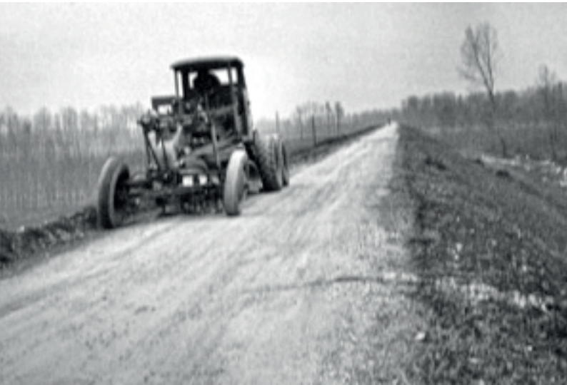
Cilindratura dell'argine Valloria
