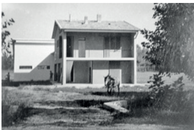
Il cantiere della Scuola Agraria di Codogno
