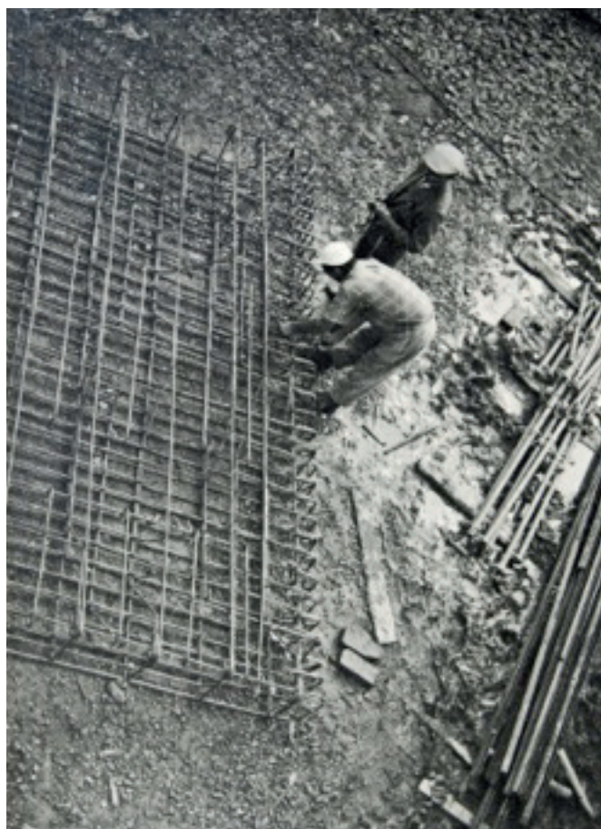
Immagini storiche di cantiere
