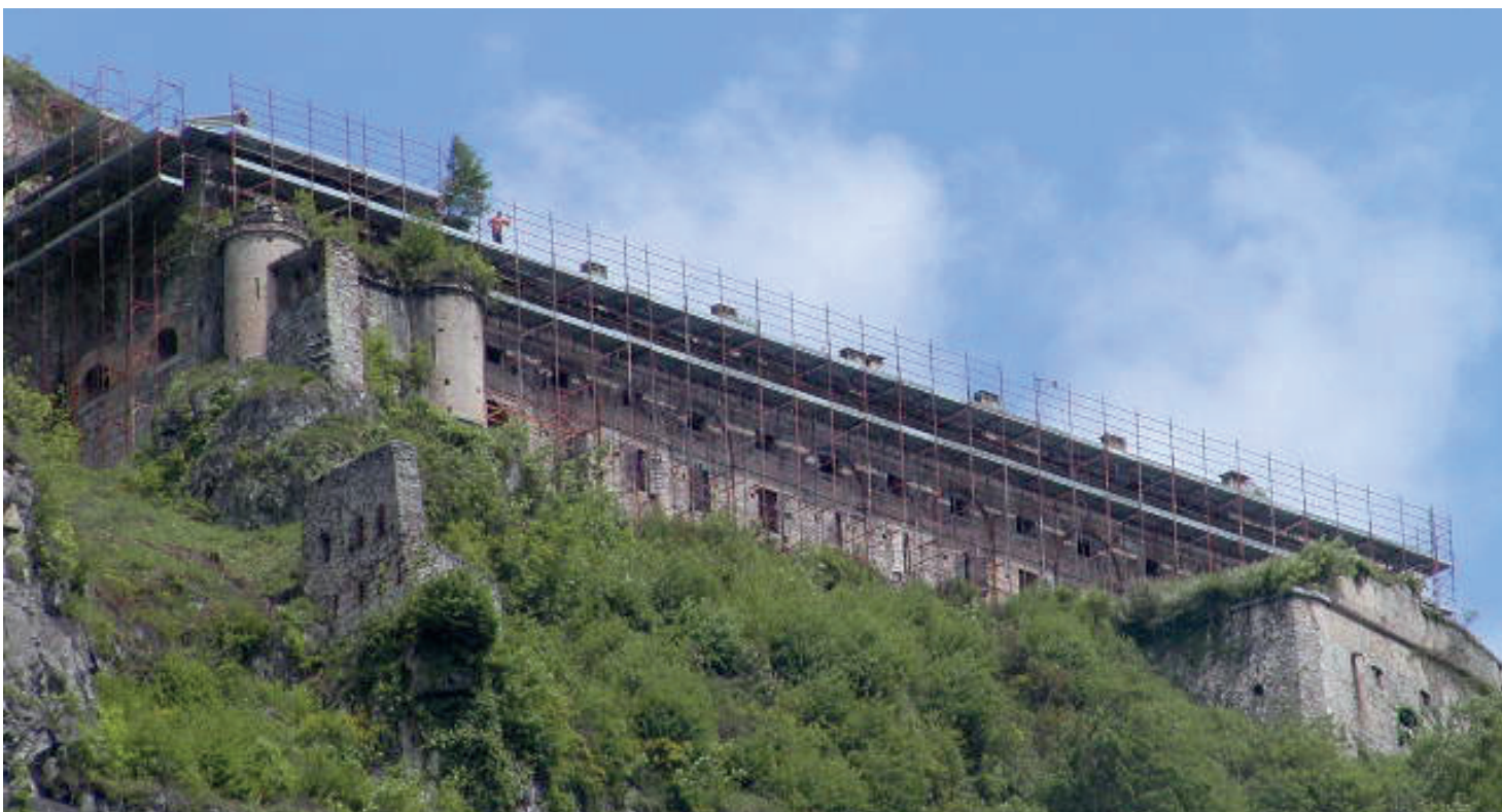
I lavori alla struttura denominata Caserma Principale Superiore nel Complesso demaniale di Rocca d'Anfo (BS)
