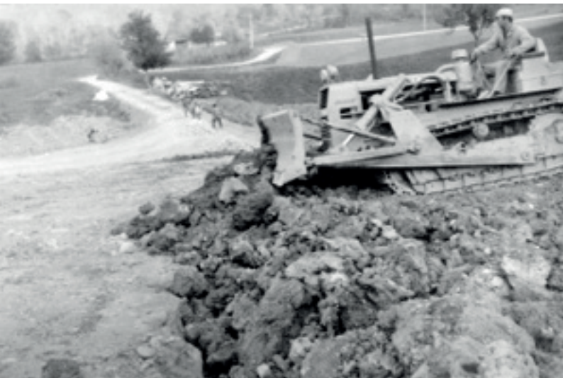
Cilindratura dell'argine Valloria
