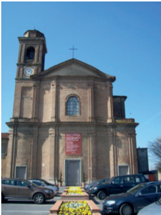
Il cantiere della Chiesa Parrocchiale Assunzione Beata Vergine Maria a Santo Stefano Lodigiano
