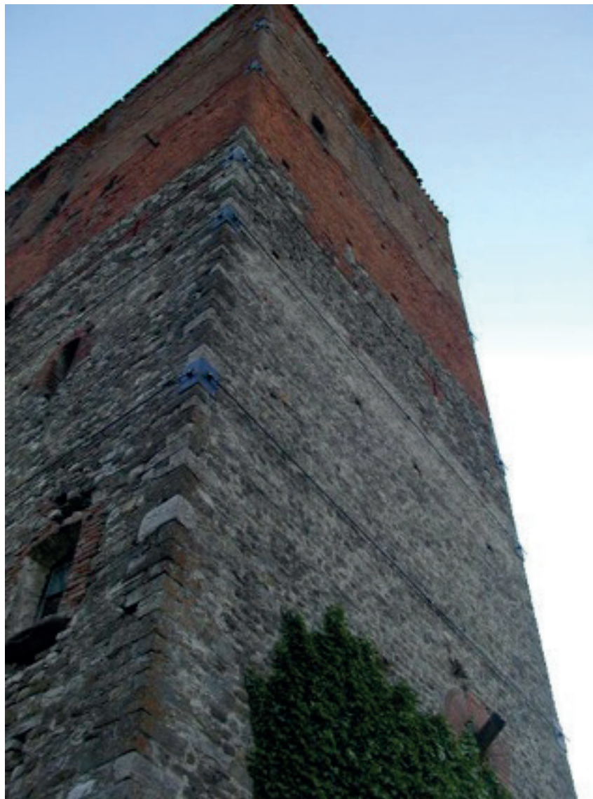
I lavori sulla Torre di Montebolzone
