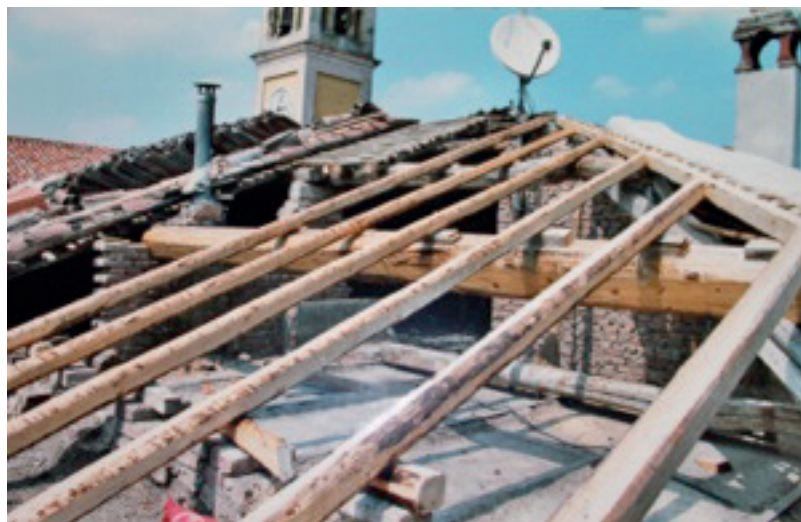
Immagine del cantiere di rifacimento di un tetto
